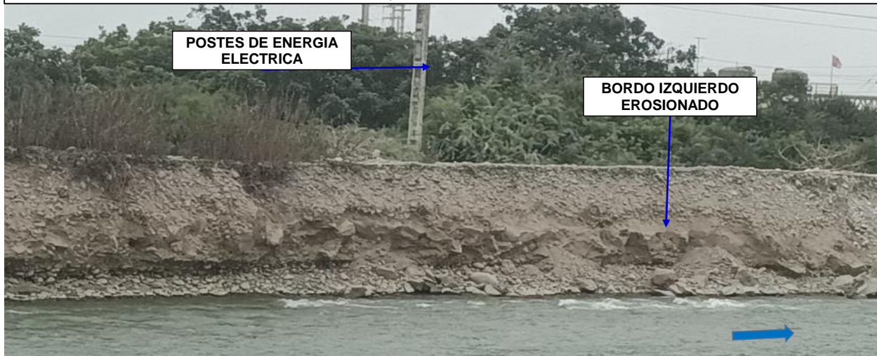
FIGURA N°02: RÍO CHANCAY HUARAL, DONDE LA MARGEN IZQUIERDA CORRESPONDE A LA ZONA DE PASAMAYO BAJO AFECTADO POR LA DEGRADACIÓN AVANZADA DE SU DIQUE DE PROTECCIÓN GENERANDO INESTABILIDAD GEOMORFOLÓGICA Y RIESGO DE
