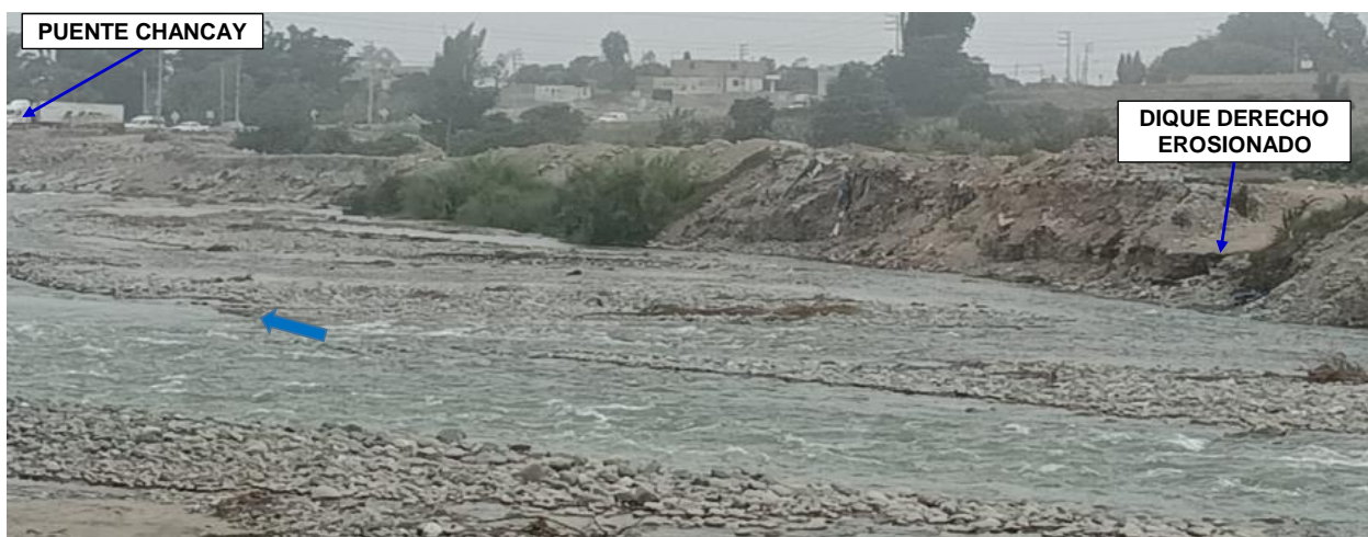
FIGURA N°04: RIO CHANCAY HUARAL, CON EL DIQUE DERECHO CONFORMADO DE MATERIAL PROPIO MUY EROSIONADO Y EL CAUCE DEL RIO COLMATADO DE FLUJO DE DETRITOS CON RIESGO DE INUNDACIÓN EN EL SECTOR.
