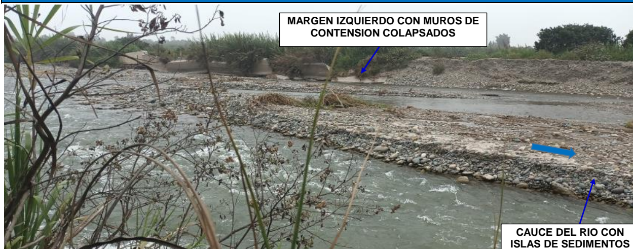
FIGURA N°01: RÍO CHANCAY-HUARAL PRESENTA CAUCE CON COLMATACIÓN CRÍTICA POR SEDIMENTACIÓN, DONDE LA MARGEN IZQUIERDA CORRESPONDE A PASAMAYO BAJO AFECTADO POR LA DEGRADACIÓN AVANZADA DE SU DIQUE DE PROTECCIÓN Y EL COLAPSO ESTRUCTURAL DE LOS MUROS DE CONTENCIÓN, GENERANDO INESTABILIDAD.
