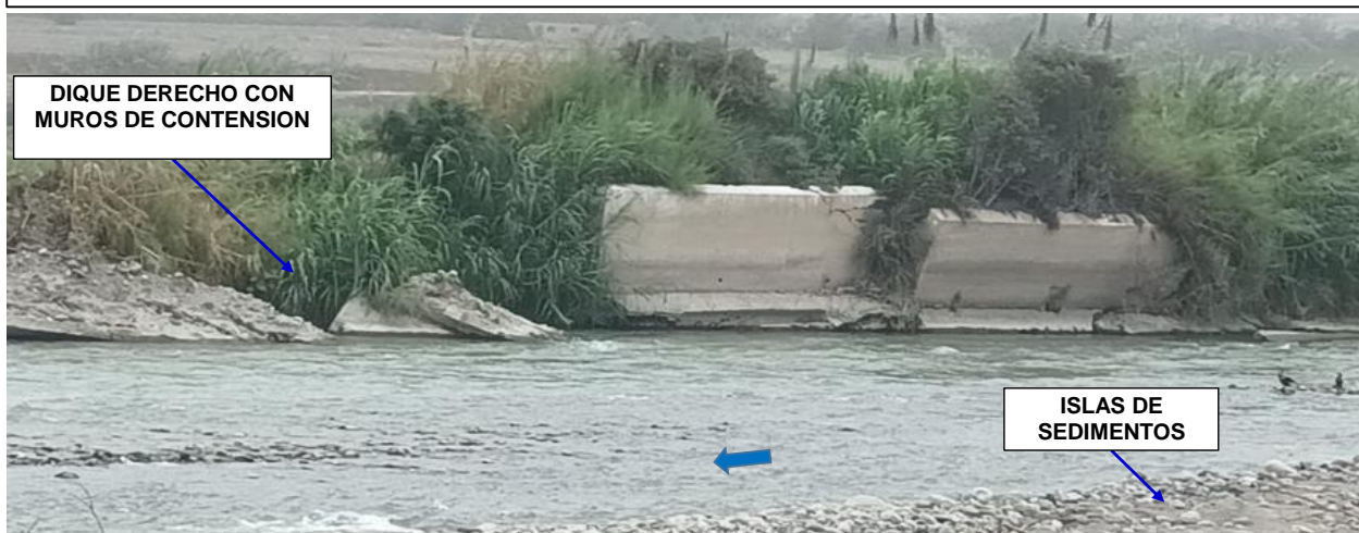
FIGURA N°03: RÍO CHANCAY HUARAL, MARGEN DERECHO, SECTOR SALINAS BAJO AFECTADO POR LA DEGRADACIÓN AVANZADA DE SU DIQUE DE PROTECCIÓN Y EL COLAPSO ESTRUCTURAL DE LOS MUROS DE CONTENCIÓN, GENERANDO INESTABILIDAD GEOMORFOLÓGICA Y RIESGO DE INUNDACIÓN EN EL SECTOR .
